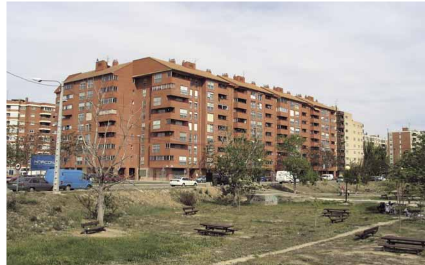
14: Existing conditions at Almozara. 14. Aspecto actual de La Almozara
