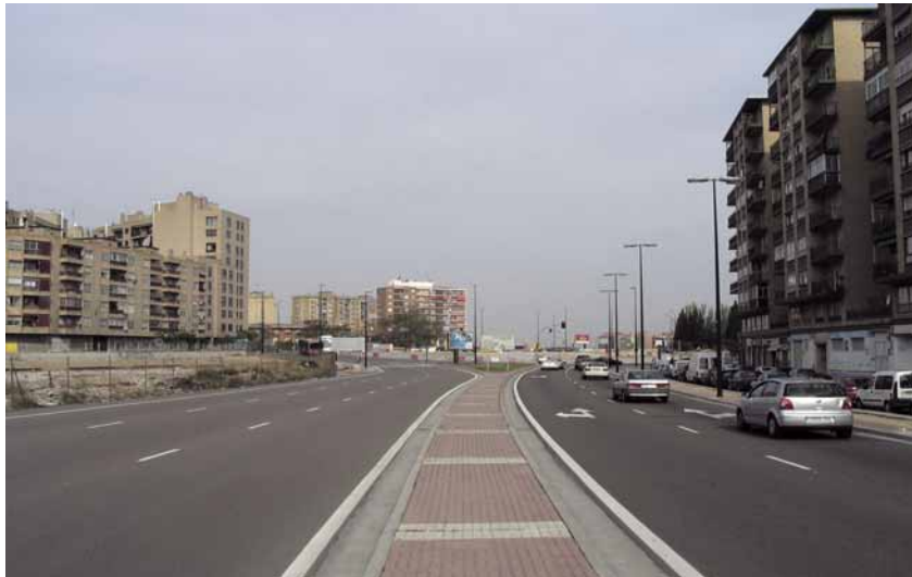
13: Existing conditions at Portillo. 13. Aspecto actual del Portillo
