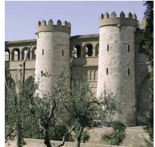
4: Aljafería towers. 4. Torres de la Aljafería
